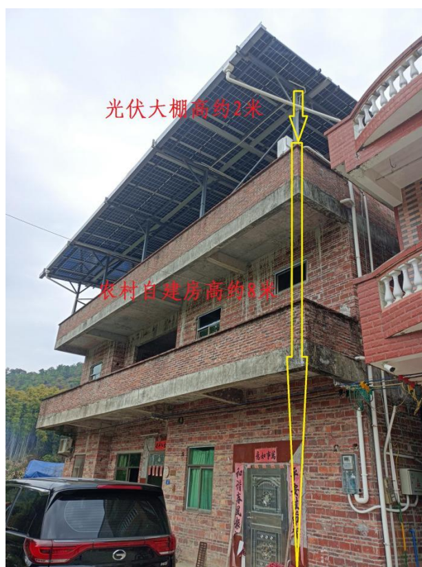
图二 农村自建房顶层现状
