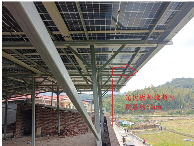
图一 农村自建房顶层现状
