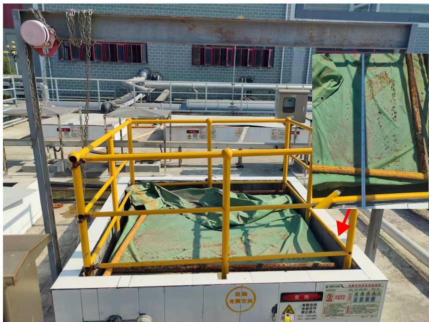
图二沼渣脱水上清液池入口为正方形边长 1.8 米
