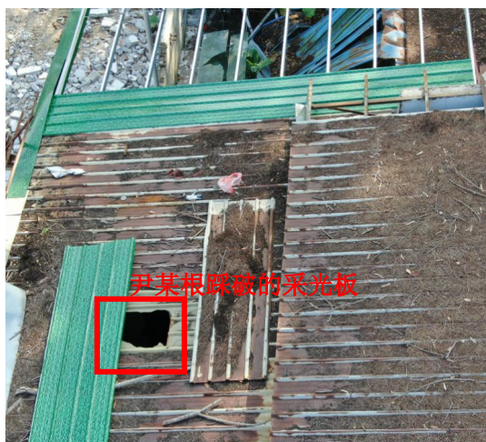
图 3 尹某根踩破采光板的位置 图 4 尹某根坠落位置
