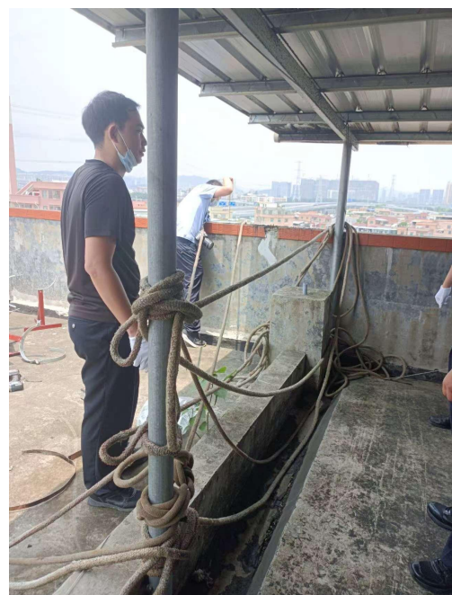
图 5、6 木制座板及散落的安全绳
