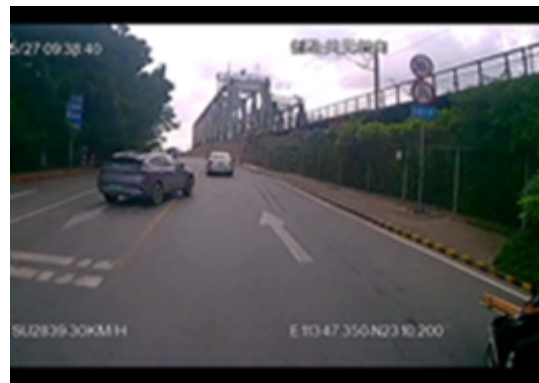
图2 石滩大桥前处两侧变窄
