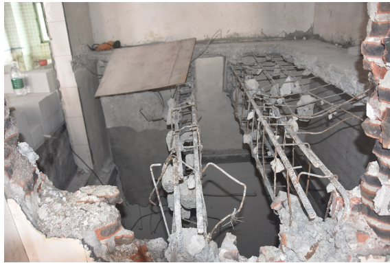
图 1 6 楼电梯机房承重层板
