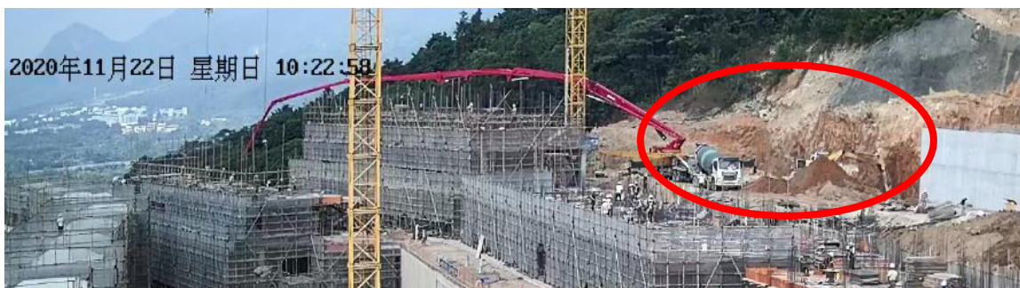
图 12 挖掘机在开挖基槽
