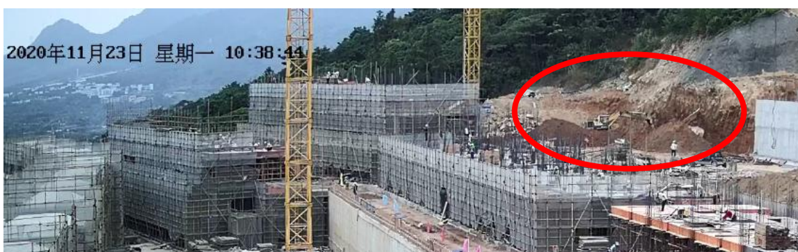
图 13 挖掘机在开挖基槽
