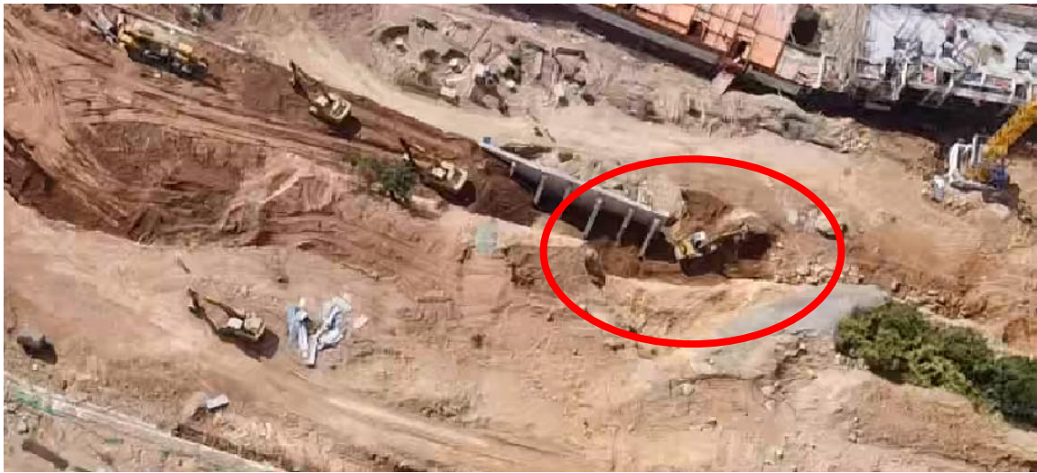
图 10 挖掘机在向挡土墙后方转运土石
