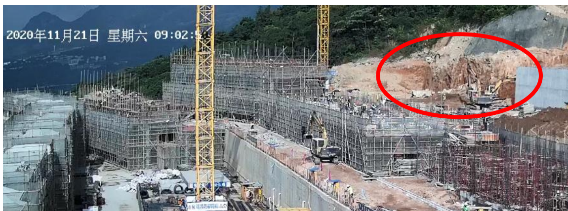
图 11 挖掘机在开挖基槽
