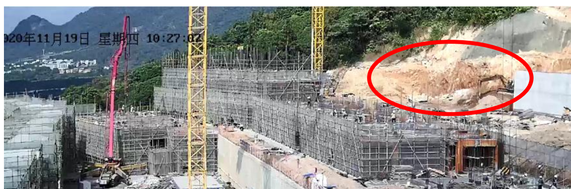
图 9 挖掘机在向挡土墙后方转运土石
