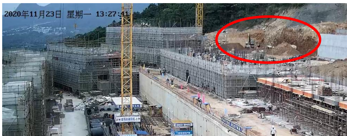
图 14 挖掘机在开挖基槽
