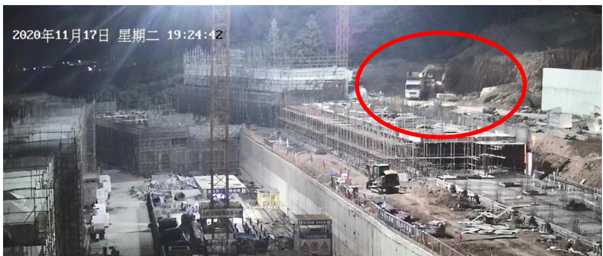
图7 挖掘机在夜间开挖山体
