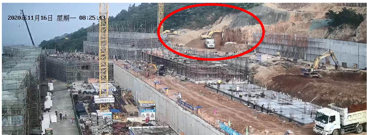
图6 挖掘机在开挖山体
