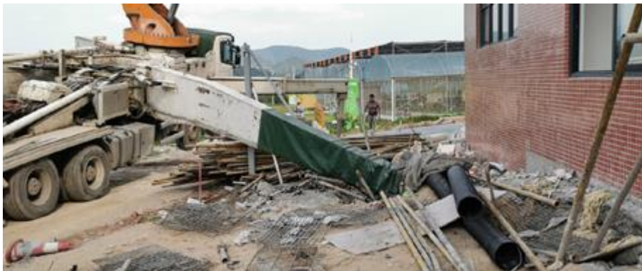
图 9、泵车作业停靠现场
